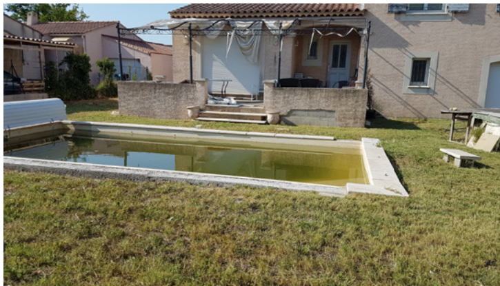
Habitat pavillonnaire avec piscine non-traitée et abandonnée
